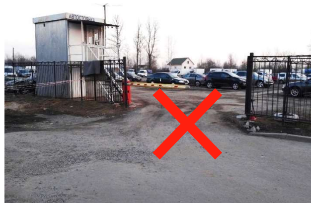
вынос грязи и щебня с территории
